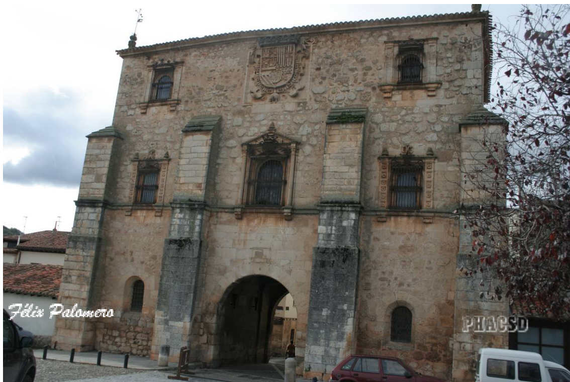
Covarrubias: edificio del archivo del adelantamiento.
